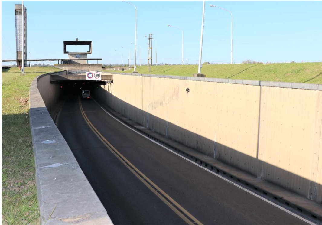
Imagen 1. Fotografía de Rampa de ingreso a Túnel Subfluvial
