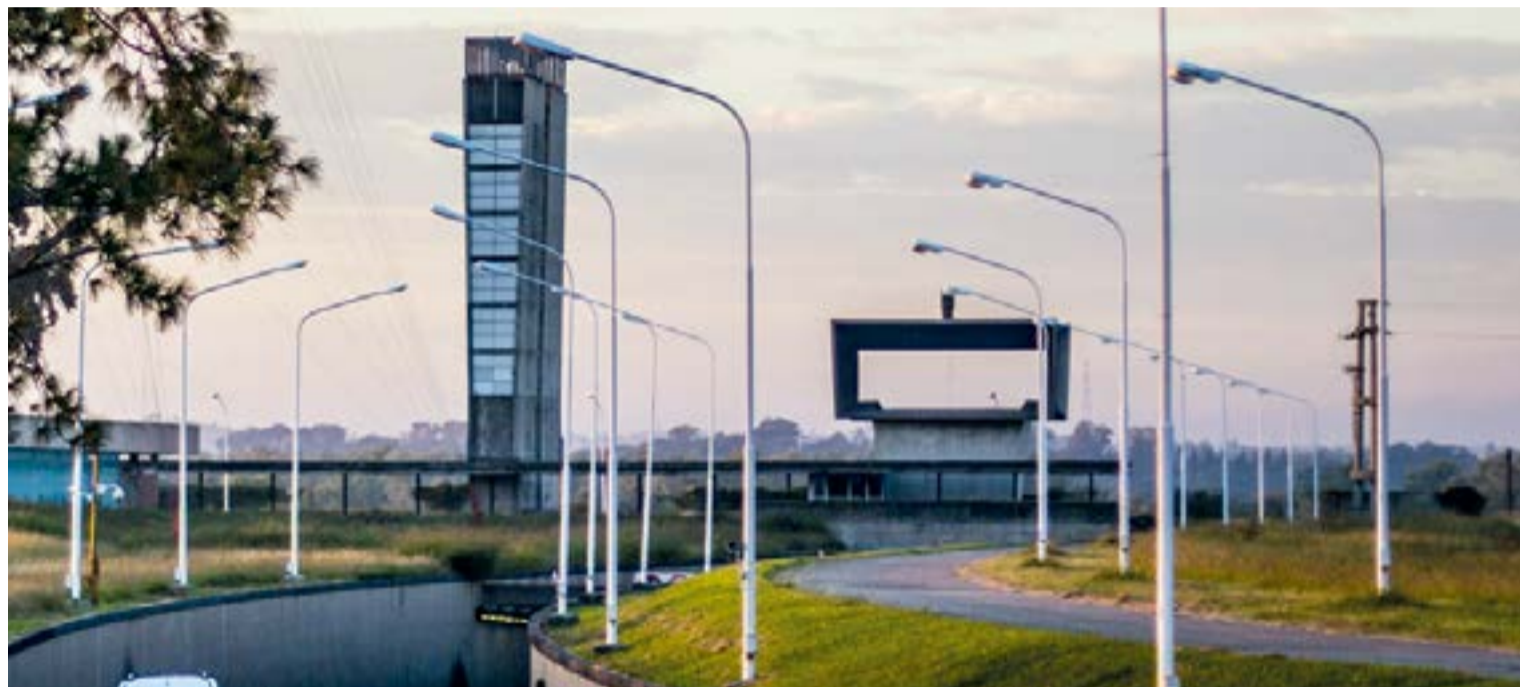
Torres de ventilación en los ingresos del Túnel Subfluvial
