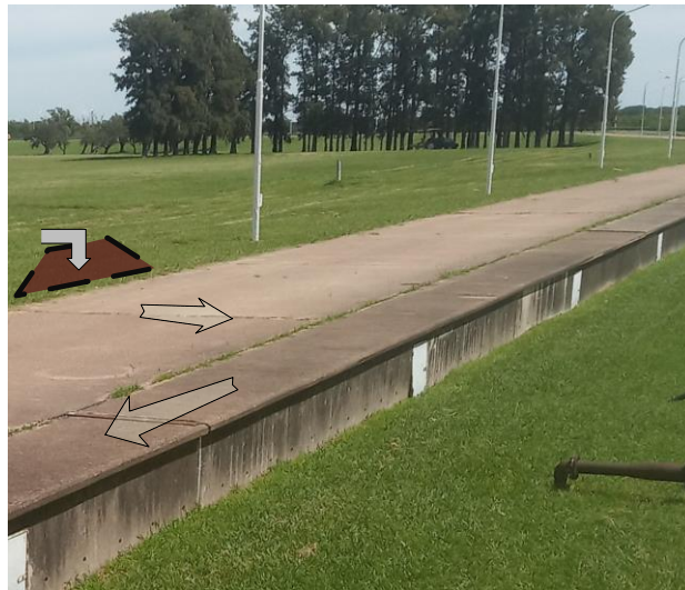
Figura 1. Transición desde zanqueo a canal de cables.
