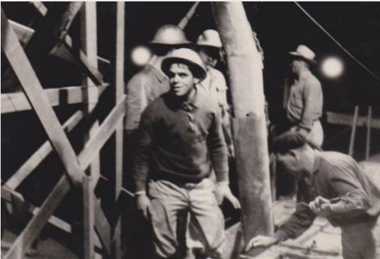
R70-20 Hormigonado Tubo 2. Vistas Nocturnas.
