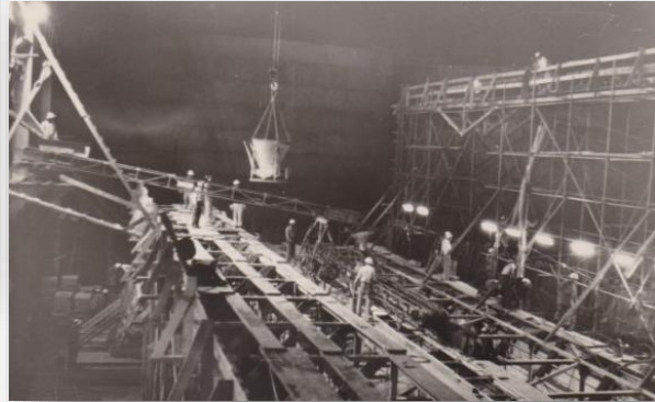
R66-11 Vistas Nocturnas del Hormigonado, parte interior Tubo 3.
