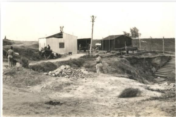
R24-30 Montaje de un galpón adicional para taller mecánico
