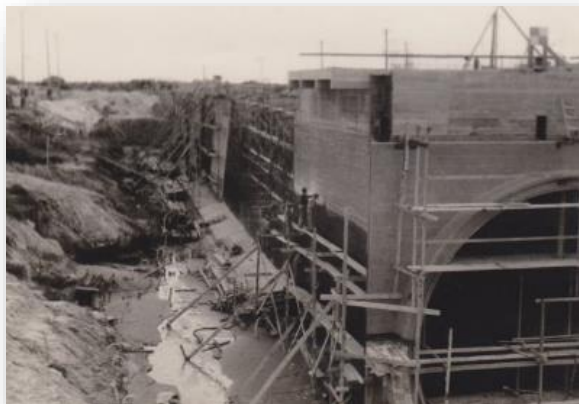
R69-10 Edificio de Ventilación Santa Fe
