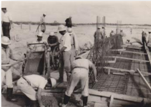
R69-07 Armaduras de bases del Edificio Administración Santa Fe
