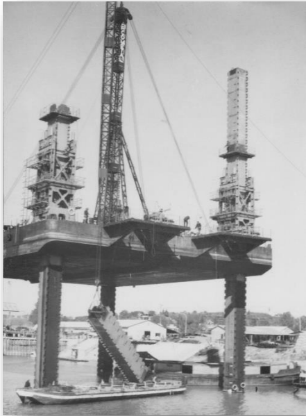
R112-29 Montaje de las prolongaciones de las columnas de apoyo de la Isla Flotante.
