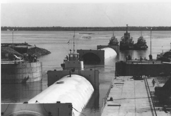
R86-22 Ubicación del remolcador que hará de timón en la parte trasera del tubo.
