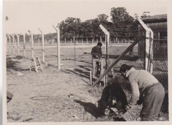
R21-11 Continúa la construcción del cerco del Obrador
