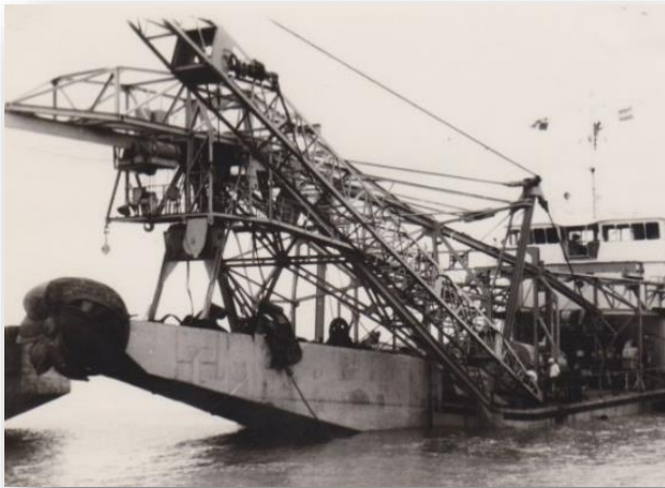
R67-17 Draga 9 en Obrador Paraná
