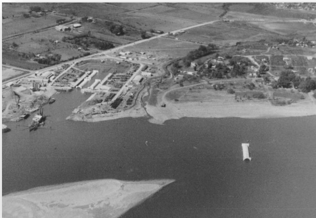
R88-35 Vista aérea del tubo n°4, varado y obrador Paraná.
