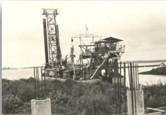
R25-10 Draga de Vianini. Atracadero izquierdo en construcción
