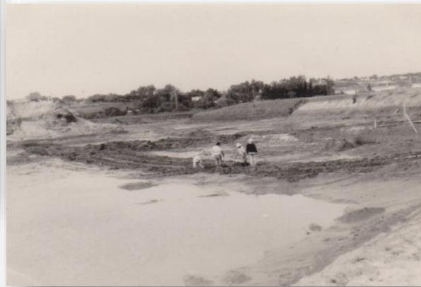
R69-16 Zona Edificio de Ventilación Paraná
