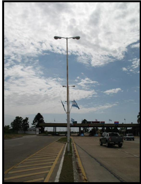
Fig. 5 Luminaria N°2 – Zona 2
