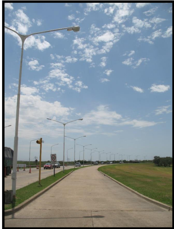
Fig. 9 Luminaria N°2 – Zona 4
