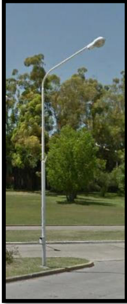
Fig. 12 Luminaria N°1 – Zona 8
