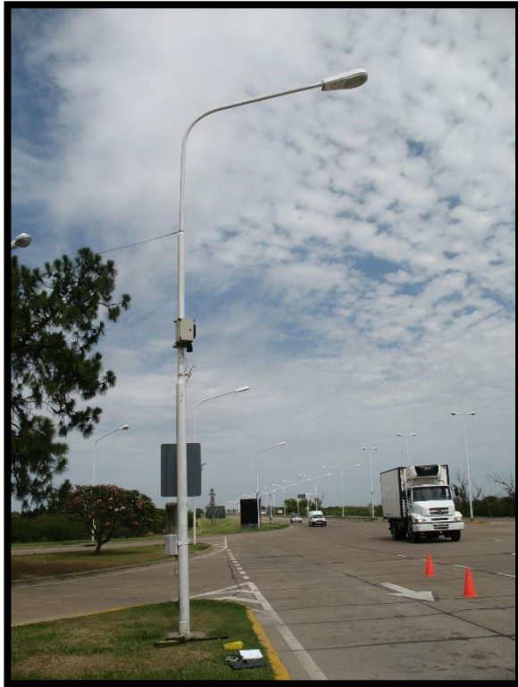
Fig. 4 Luminaria N°1 – Zona 2
