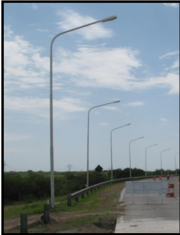
Fig. 8 Luminaria N°1 – Zona 4
