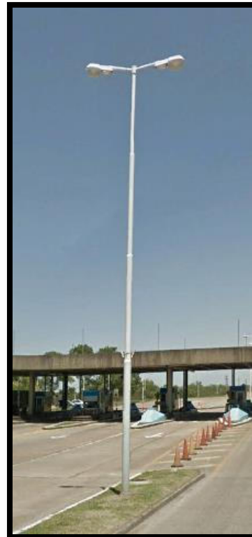
Fig. 7 Luminaria N°2 – Zona 3
