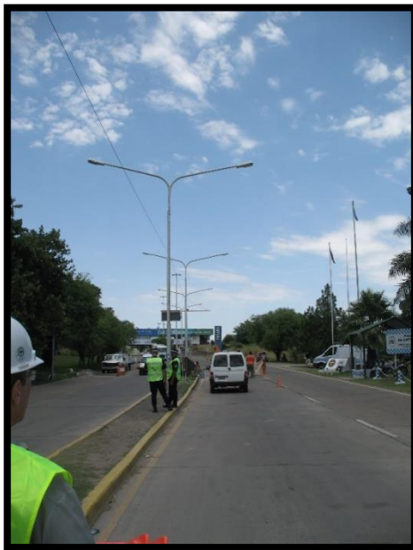
Fig. 14 Luminaria N°3 – Zona 8
