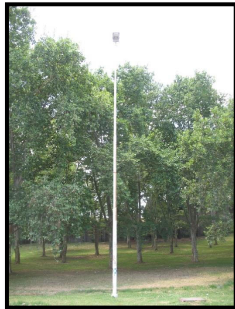
Fig. 15 Luminaria N°4 – Zona 8
