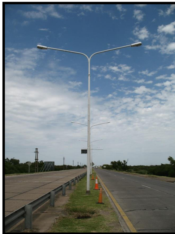
Fig. 3 Luminaria N°1 – Zona 1
