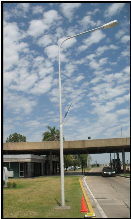
Fig. 6 Luminaria N°1 – Zona 3
