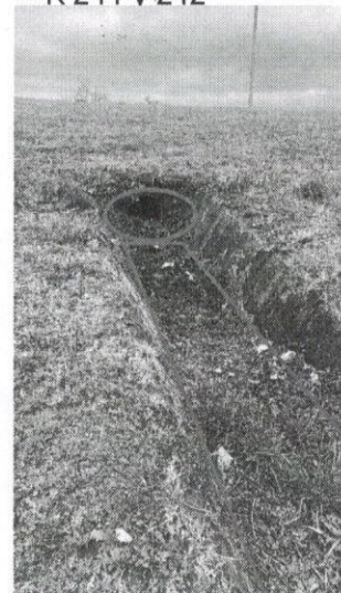
Boca y cuneta a cielo abierto K 241 y 242
