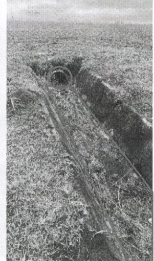
Boca y cuneta a cielo abierto K 232 y 233
