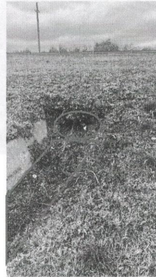
Boca y cuneta a cielo abierto K 238
