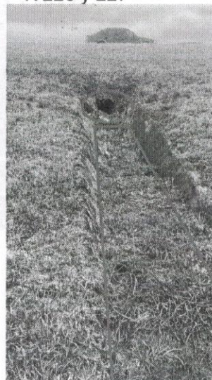
Boca y cuneta a cielo abierto K 226 y 227
