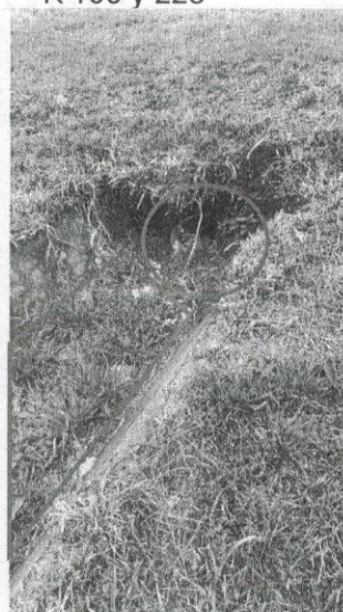
Boca y cuneta a cielo abierto K 100 y 223
