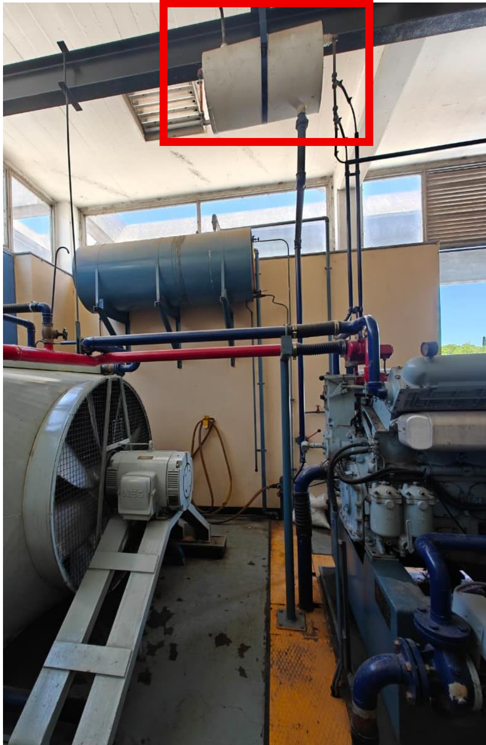
Figura 1 – Zona de trabajo T. Agua: El tanque de agua se encuentra ubicado a aproximadamente 4 metros de altura.
