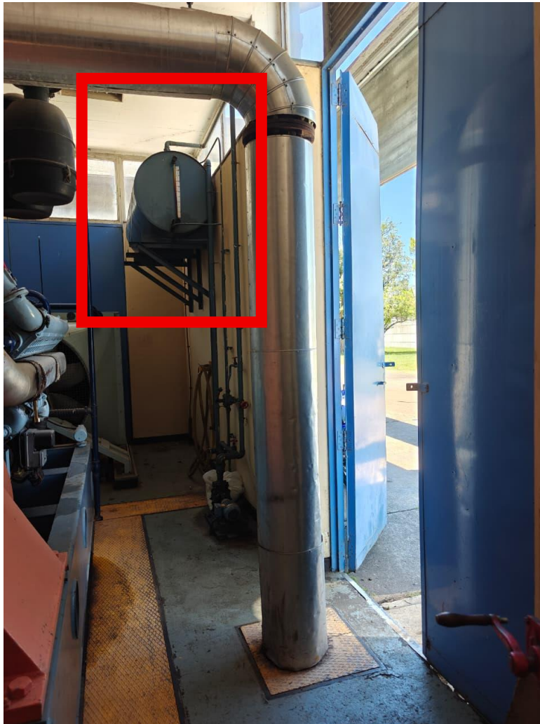
Figura 2 – Zona de trabajo T. Combustible: El tanque de combustible se encuentra ubicado a aproximadamente 3 metros de altura. El pasillo de acceso al área tiene un ancho libre de 1 metro.
